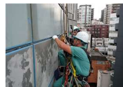
外壁の漏水調査も
