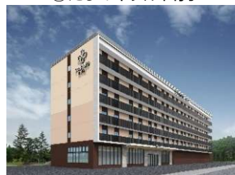
建物外観パース
