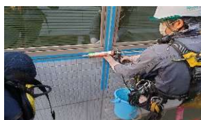
無足場工法での補修工事
