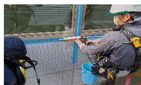
無足場工法での補修工事
