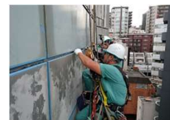
外壁の漏水調査も
