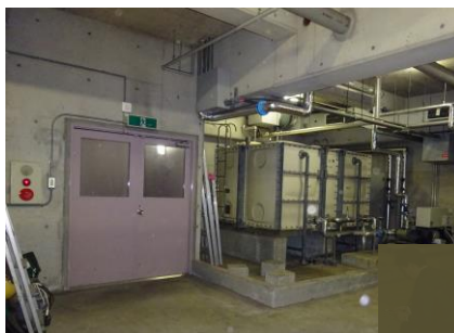
エレベーターも無く、未活用だった地下1F倉庫
