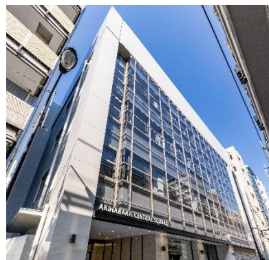
東京都千代田区神田佐久間町 一棟収益ビル
