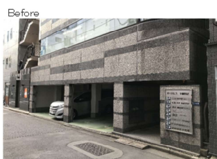
Before 低稼働で収益性が落ちていた1階の駐車場
