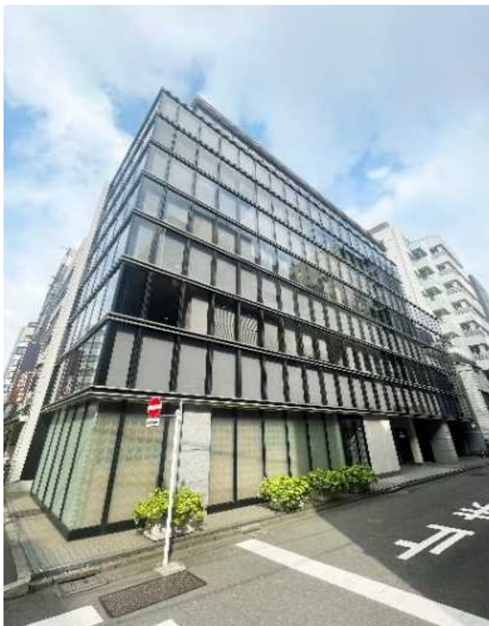
【建物外観(リプランニング後)】 東京都千代田区神田須田町 一棟収益ビル 鉄骨・鉄骨鉄筋コンクリート造陸屋根地下1階付8階建
