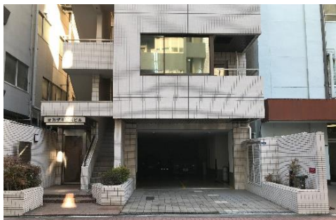
1Fは暗い駐車場
