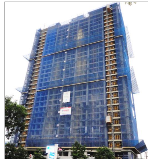
1月に上棟を迎え、現在内装仕上げ工事中
