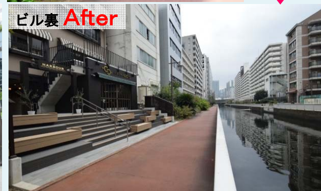
階段状のベンチを新設し、運河側遊歩道と接続
