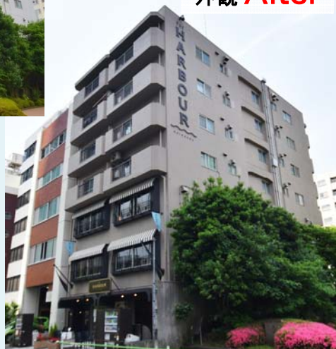
耐震補強工事を実施、安心を創造
